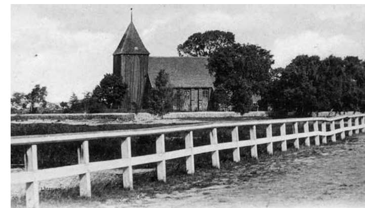
Brückendamm Baujahr 1874 vor der Seemannskirche.
