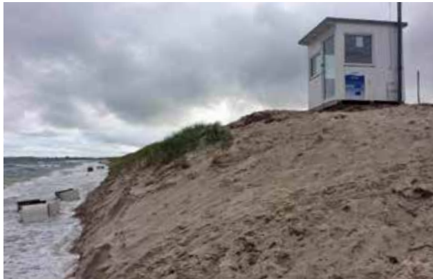
Abbruch am Strand von Neuhaus (bei Dierhagen). Foto: S. Schneider/StALU
